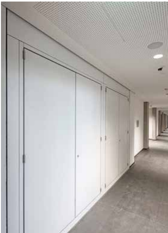
BRANDSCHUTZTECHNISCHE ABTRENNUNG von Elektroverteilern gegenüber den notwendigen Fluren. Auf mehreren Etagen wurde das Wandsystem Priowall in Verbindung mit großformatigen, zweiflügeligen Revisionsabschlüssen Priodoor ETX verbaut.
