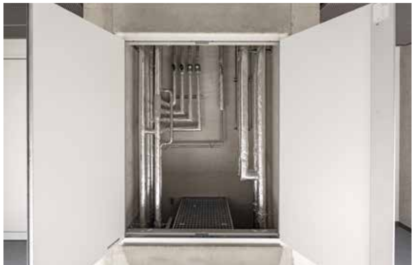
BRANDSCHUTZTECHNISCHE ABTRENNUNG von Elektroverteilern gegenüber den notwendigen Fluren. Auf mehreren Etagen wurde das Wandsystem Priowall in Verbindung mit großformatigen, zweiflügeligen Revisionsabschlüssen Priodoor ETX verbaut.
