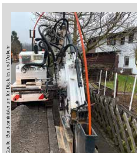
24 Glasfaserverlegung im Gehwegbereich
