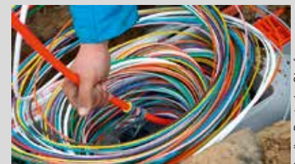
Quelle: Deutsche Glasfaser
