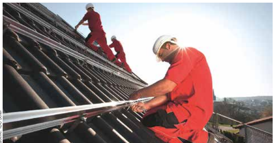
② Die Installation von PV-Anlagen auf kleinen Hausdächern ist rückläufig
