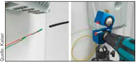
30 Einblasen vorkonfektionierter Leitungen E3S Connect
