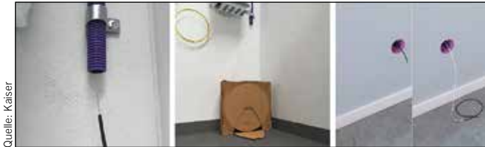
29 Einschieben vor-konfektionierter Leitungen E3S Connect
