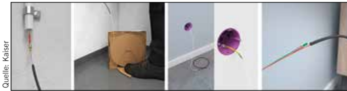
28 Einziehen vor-konfektionierter Leitungen E3S Connect
