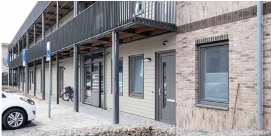
Das dreigeschossige Mehrfamilienhaus in Losser wurde aus Containern errichtet.
