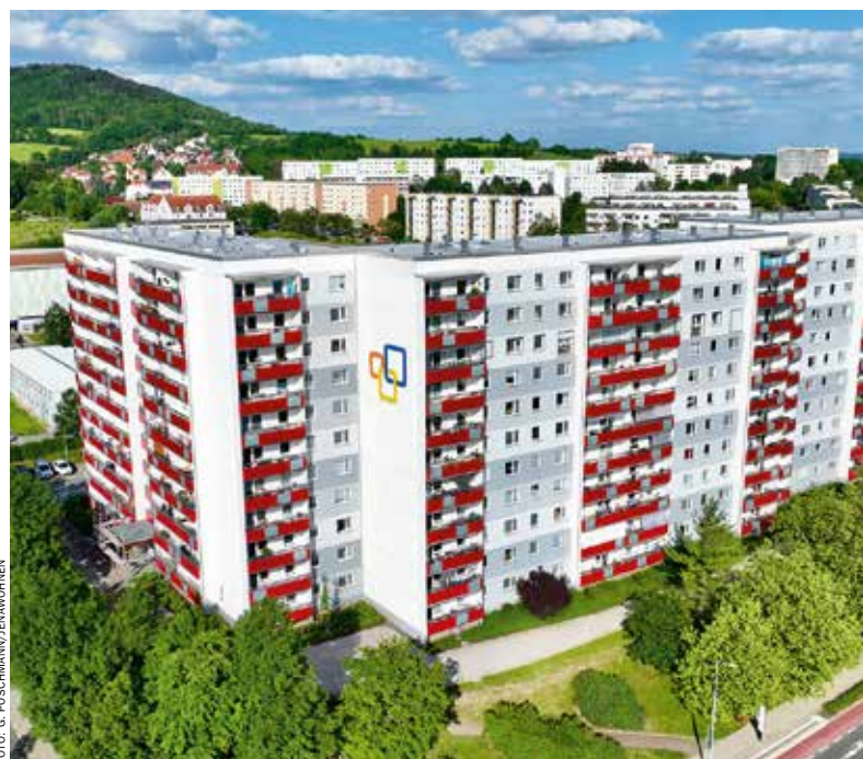
Smartes Quartier in Jena, in dem Erzeugung, Verteilung und Abnahme von Wärme ideal abgestimmt sind.
